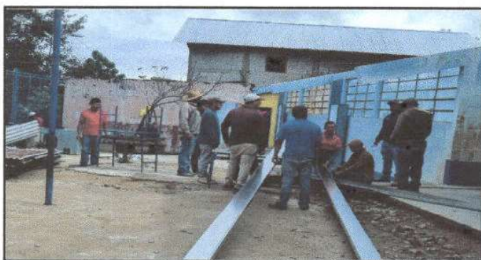
Foto 5: Sustrución de estructura de metal de techo del módulo de 2 aulas donde será sustruida la lámina.
