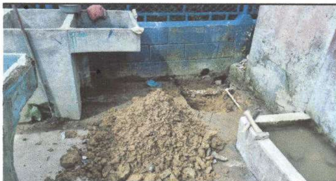
Foto 3: Sustrución de caja No. 1 de registro, incluye sustrución de tubos de 6 pulgadas.
