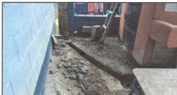
Foto 4: sustrución de caja No. 2 de registro que incluye sustrución de tubos de 3 pulgadas
