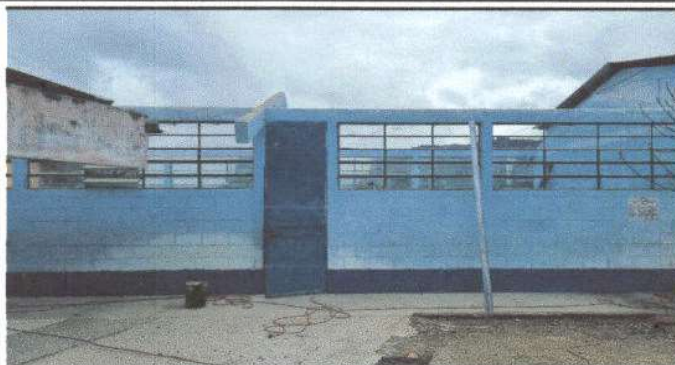
Foto 1: Sustrución de techo de un módulo de dos aulas.
